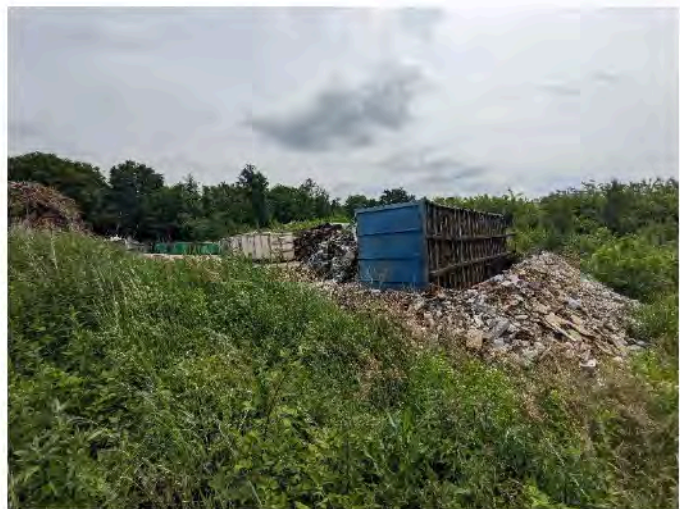
Figure 10 - Photographie du remblai
