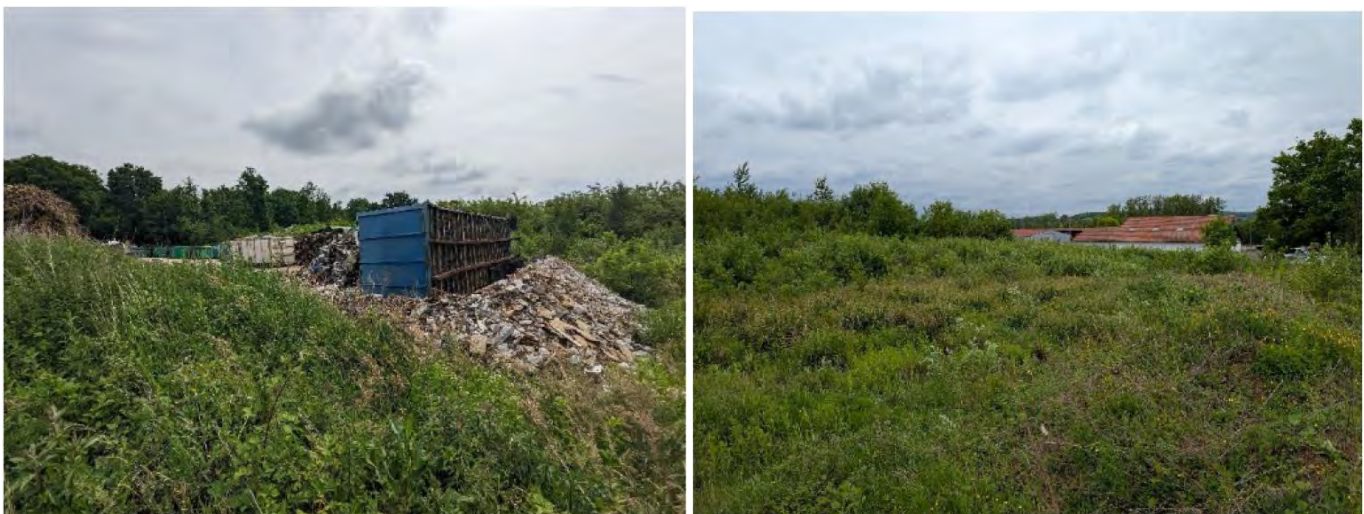
Vue générale de la parcelle du projet : remblais (gauche) et prairie humide (droite) – Source : Faune Flore & Environnement, 2025
