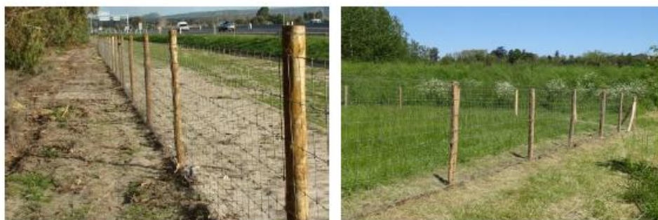
Figure 38 : Exemple d'une clôture de parc solaire – Source Melvan
