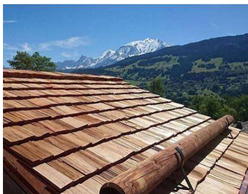
Exemple toiture en tavaillons
