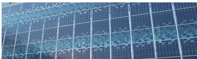
Visuel de panneaux photovoltaïques semi-transparents disposés verticalement en façade. Photographie : 2ES, à Schneider Electric Grenoble
