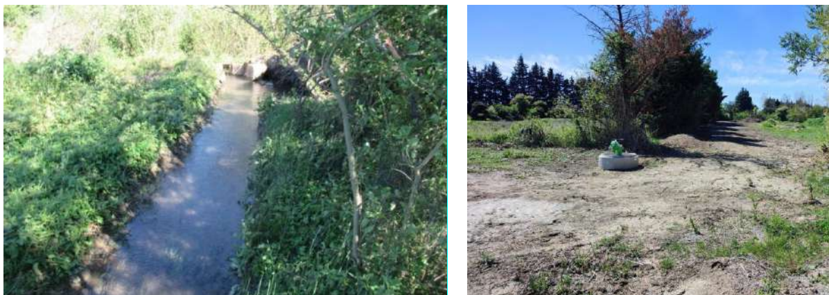
Figure 24 : Illustrations de l'évolution du fossé en 2020 (à gauche), busé et enterré en 2023 (droite). Photos sur site : Naturalia
