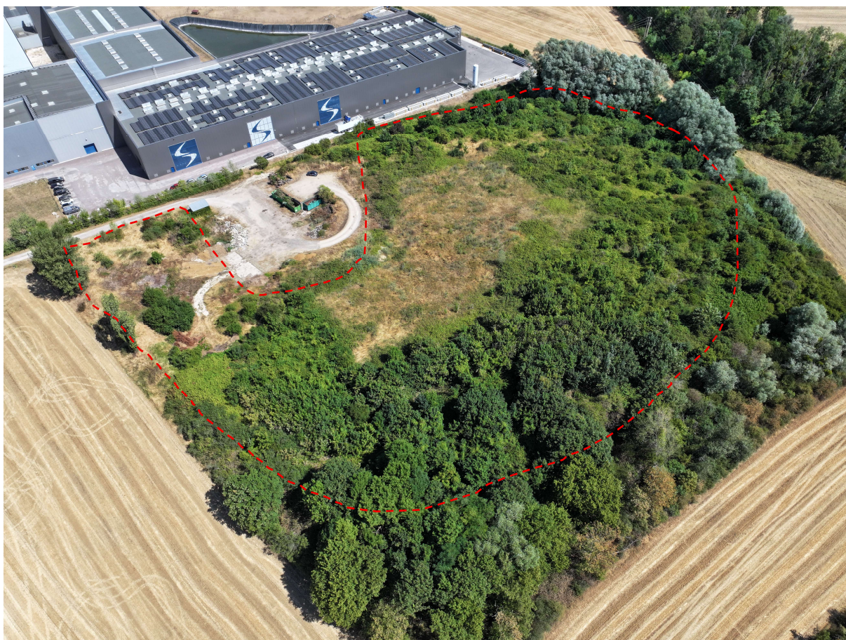
FIGURE 6 : VUES DU SITE (07/07/2026)
