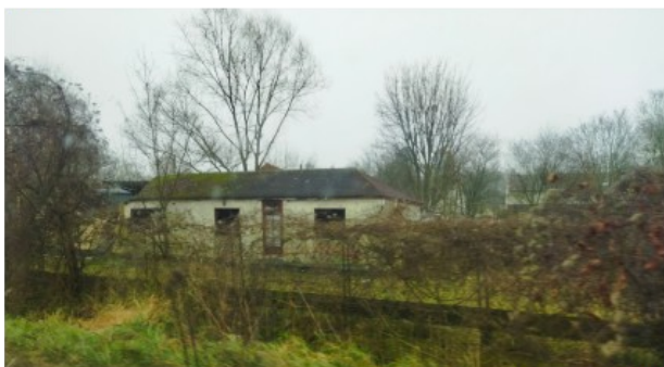
Vue depuis la RN 3 sur les bâtiments présents sur le site.
