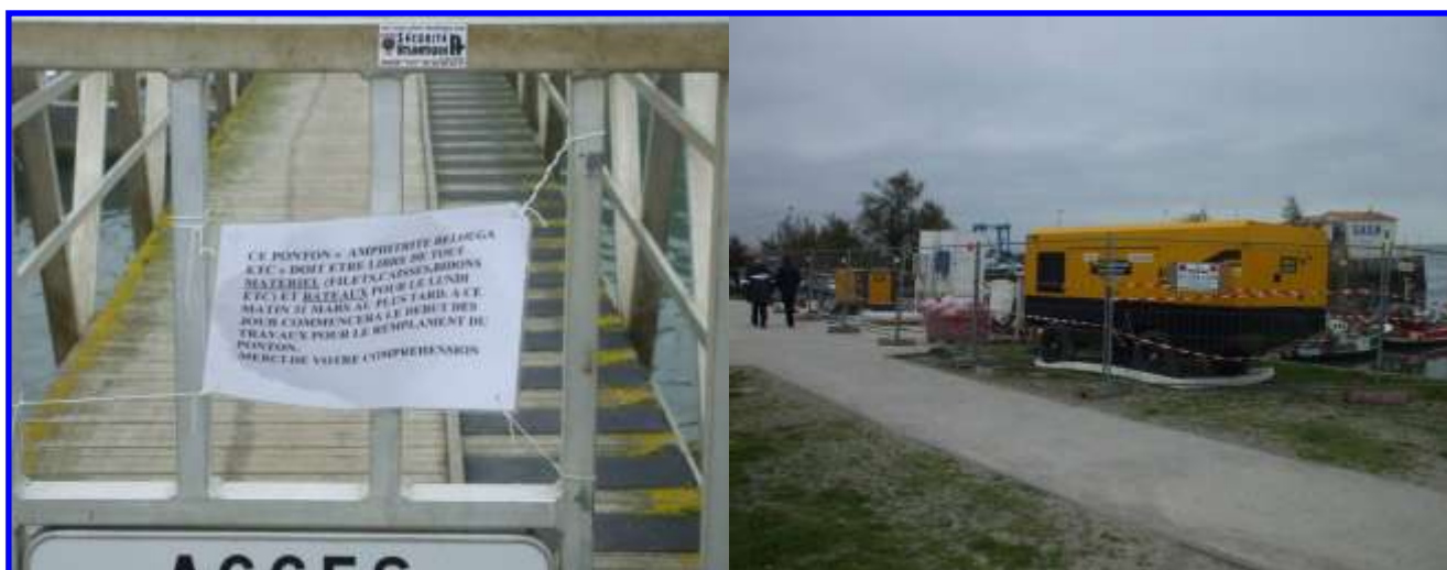
Figure 47 : Exemples d'information et de limitation de la zone relative au chantier.
