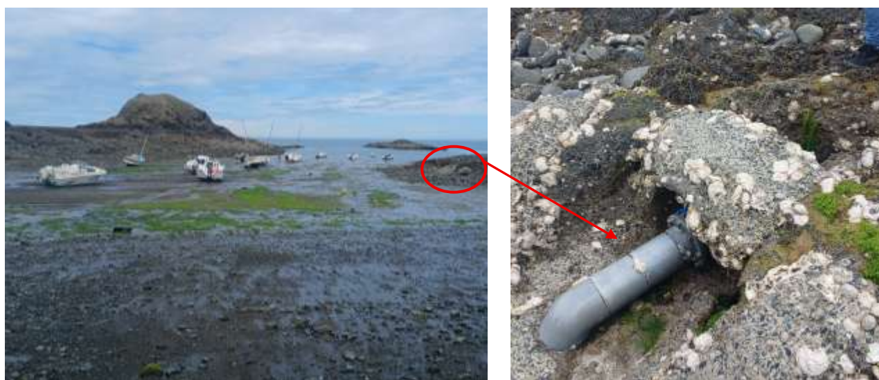
Figure 8 : Vue de la prise d'eau de mer des Viviers de St Marc sur le site.
