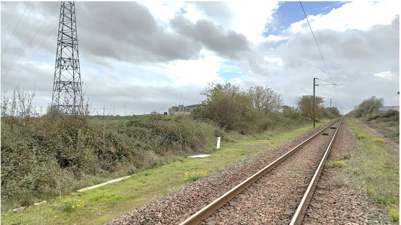
Figure 26 : Point 3 - Prise de vue vers le sud (date de prise de vue : 07/11/2025)
