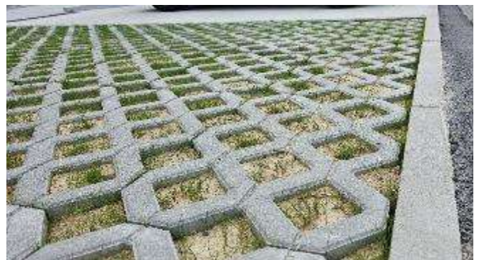
Figure 9 : béton alvéolé (Saint-Malo - 2025)
