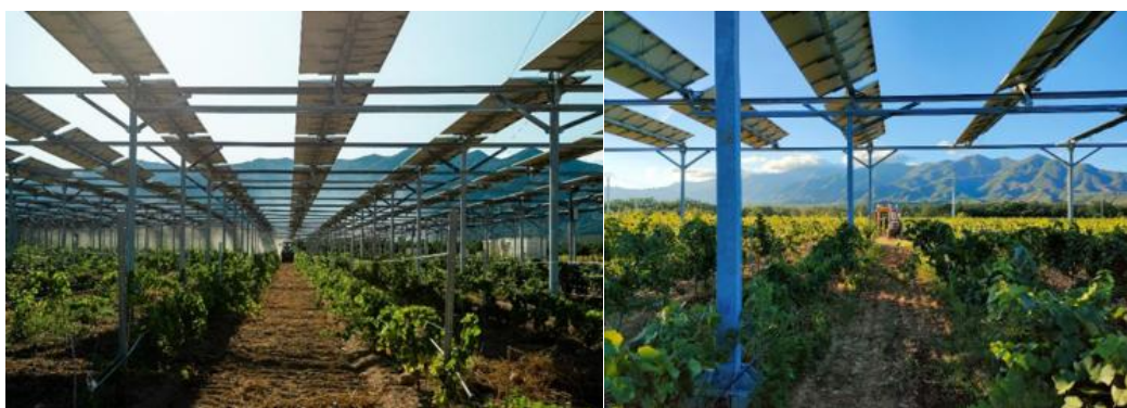
Figure 24 : Cohabitation vigne et structure sur le site de Tresserre (source : Sun'Agri, décembre 2023) La présence de culture en dessous des panneaux vient atténuer l'aspect « métallique »
