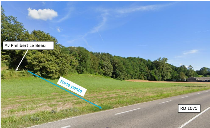
Figure 38 : Origine des eaux depuis l'espace vert entre la RD1075 et l'avenue de Philibert Le Beau
