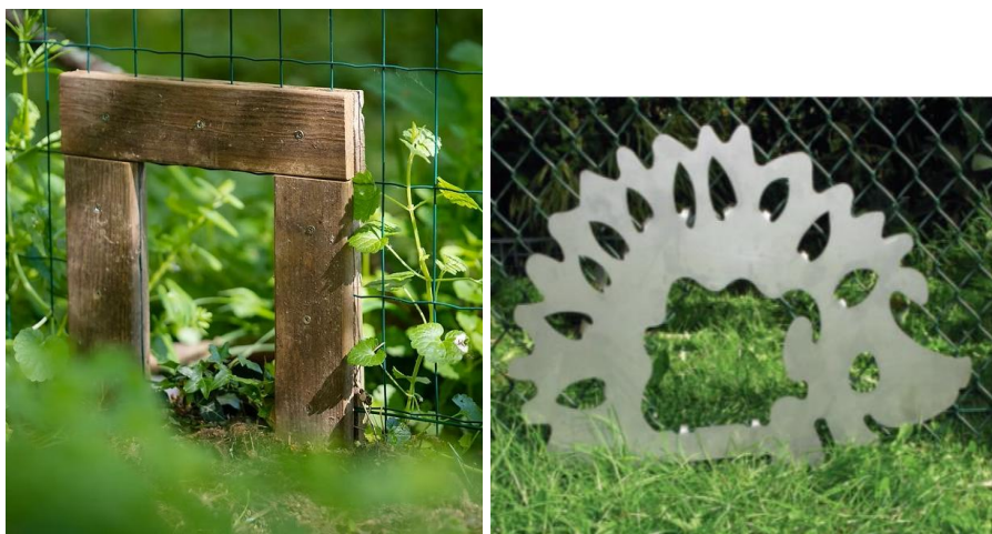
Figure 81 : exemples de passages aménagés pour la faune dans les clôtures (source : VNEI – ECOLOR)
