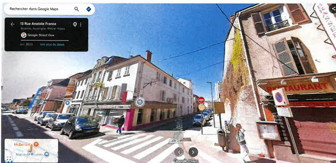
A l'angle de la rue Anatole France et rue J Déchelette – immeubles à démolir
