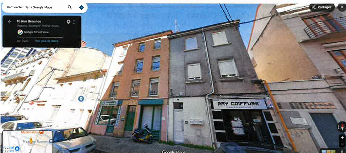
Rue Beaulieu – immeubles à démolir
