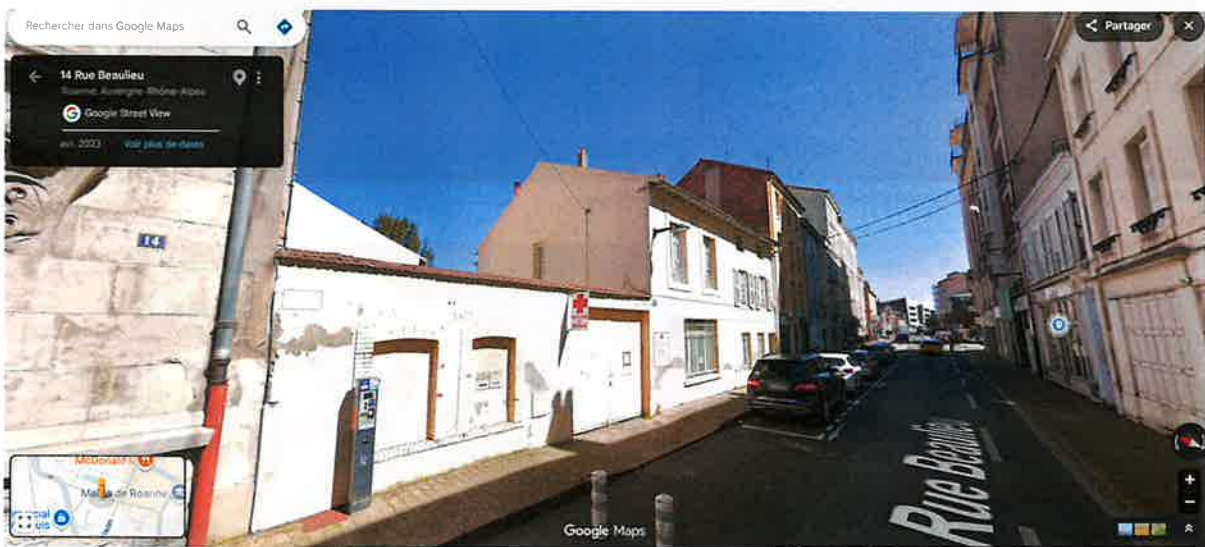
Vue rue Beaulieu – immeuble à démolir
