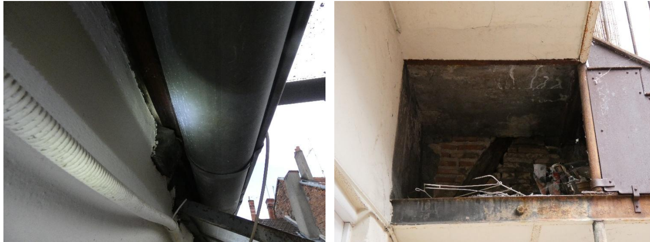
Figure 28 : Interstice entre les chenaux et la toiture à gauche et renforcement dans la façade à droite © EODD, 2026
