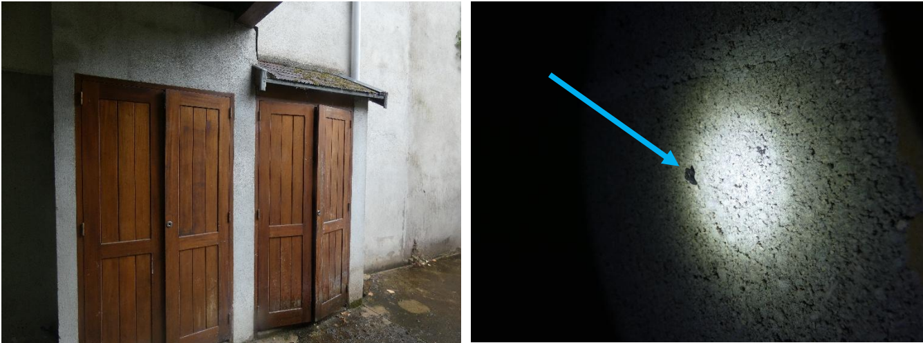
Figure 17 : Compteur d’énergie à gauche et excrément retrouvé à droite © EODD, 2026
