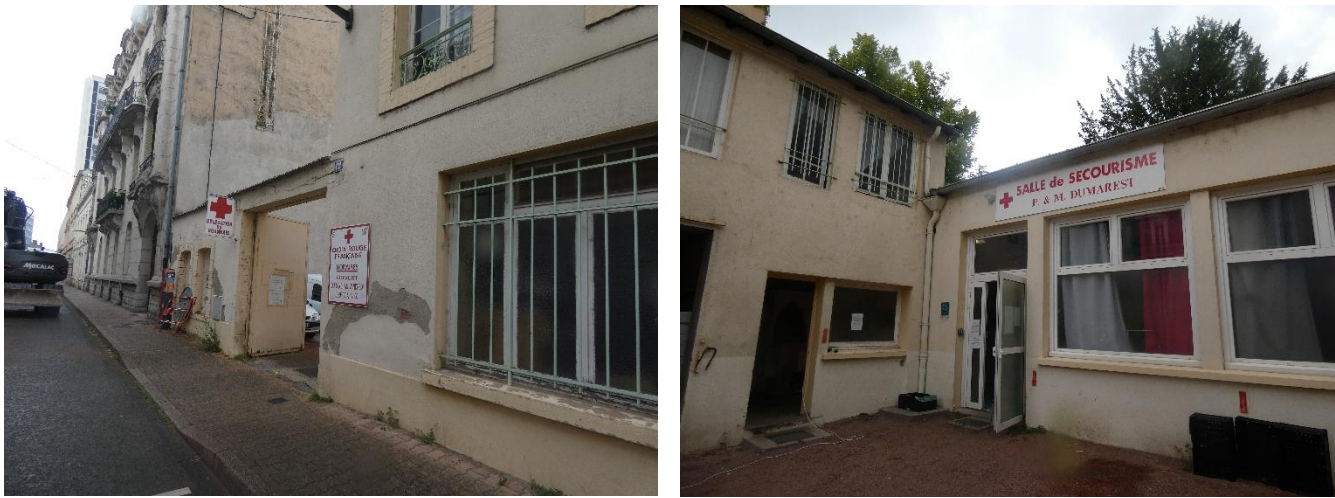
Figure 9 : Accès de la croix rouge depuis la rue à gauche et depuis la cour intérieure à droite © EODD, 2026
