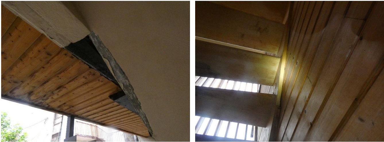
Figure 22 : Bardage bois du haut de la cage d'escalier © EODD, 2026
