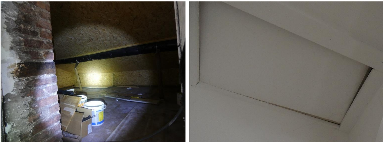
Figure 33 : Espace sous la toiture à gauche et trappe d'accès aux combles à droite © EODD, 2026
