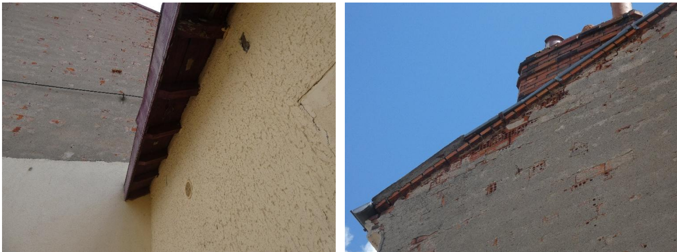
Figure 32 : Avancé de toit à gauche et briques alvéolaires à droite © EODD, 2026
