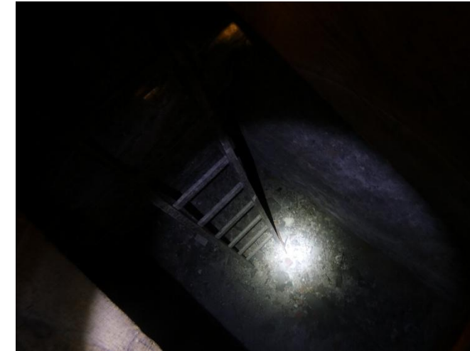
Figure 43 : Vide sanitaire sous la bibliothèque © EODD, 2026
