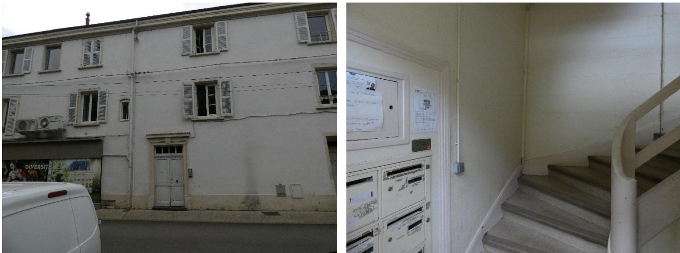
Figure 24 : Bâtiment vu depuis la rue Joseph Déchelette à gauche et son hall d'entrée à droite © EODD, 2026
