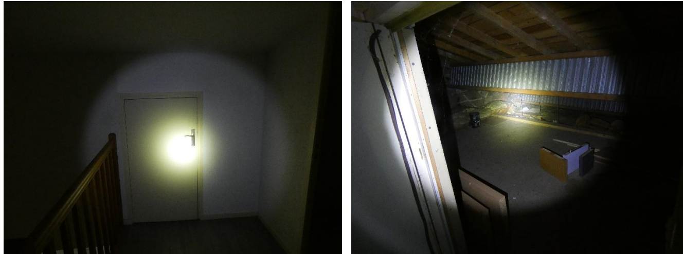
Figure 18 : Pièce sous la toiture © EODD, 2026
