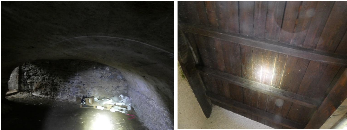
Figure 15 : Cave à gauche et son appentis à droite © EODD, 2026
