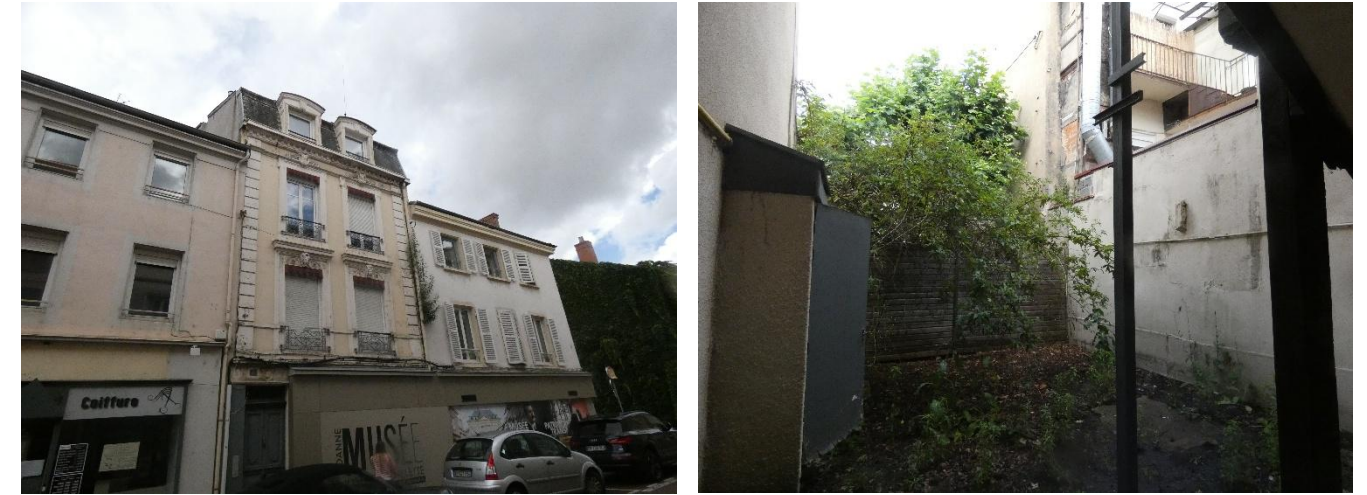
Figure 19 : Vue depuis la rue à gauche et arrière-cours à droite © EODD, 2026
