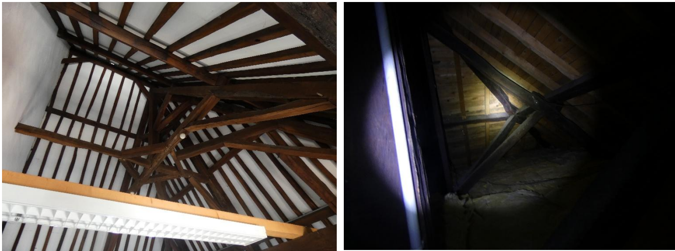
Figure 48 : Charpente du dernier étage à gauche et espace accessible depuis une des trappes dérobées à droite © EODD, 2026
