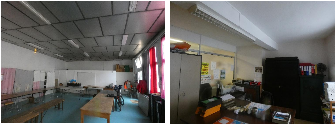
Figure 10 : Grande pièce d’accueil à gauche et bureau à droite © EODD, 2026
