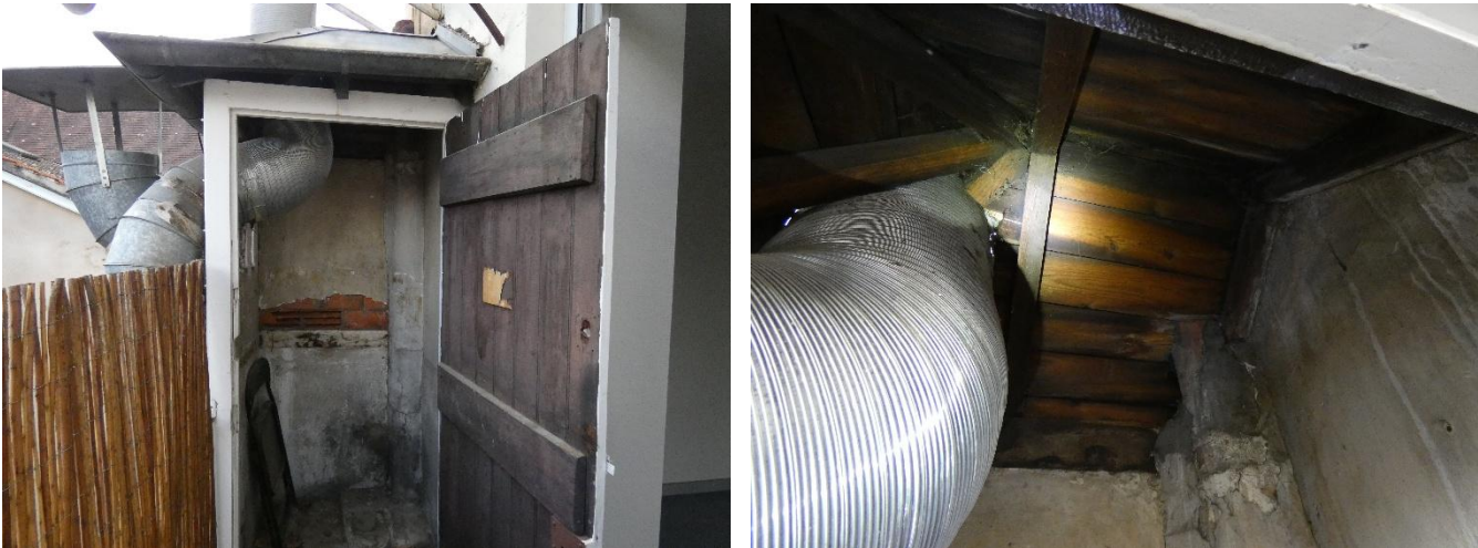
Figure 27 : Petit local présent à l'extrémité ouest du balcon du deuxième étage © EODD, 2026
