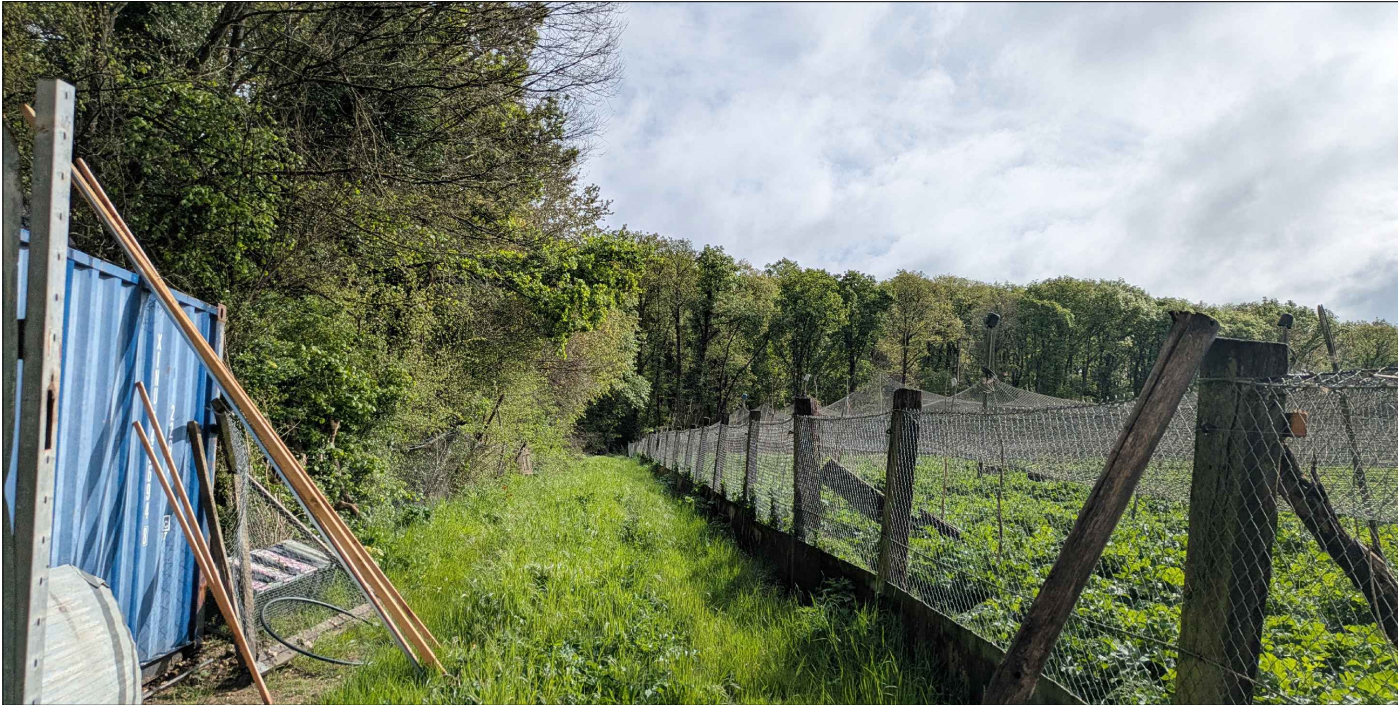
Vue depuis l'accès, au Nord du projet
