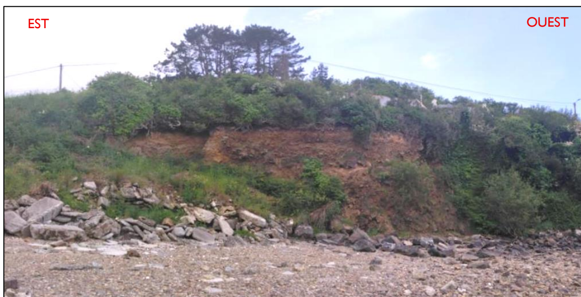
Vue générale depuis l'Estran au Nord – 2025-05-13
