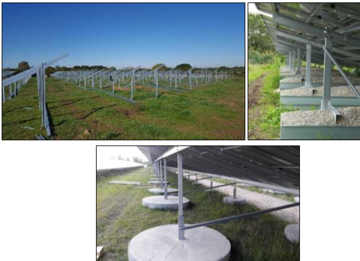
Figure 74 : Mise en place des structures sur pieux battus (centrale JPee de Braize, 03), structures en bac acier (centrale JPee de Questembert, 56) et structures en longrines béton (centrale JPee de Labarde, 33)
