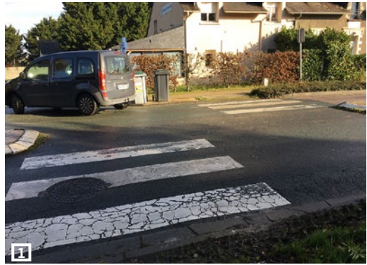
Au Nord du site, manque de traversées sécurisées de la rue de la Liberté, qui est très passante, vers la zone commerciale.
