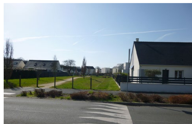
Maisons le long des espaces verts avec liaisons douces
