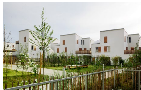
Logements intermédiaires - St Jean de Braye // Dumont Legrand Architectes
