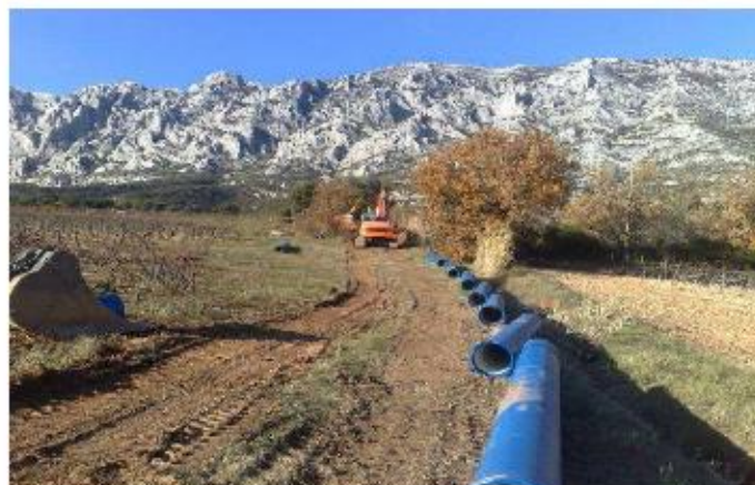
Emprise de travaux durant la pose de canalisations
