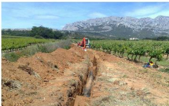
Emprise de travaux durant la pose de canalisations
