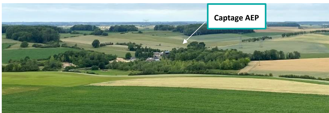
Figure 13 : Vue en hauteur du réservoir d'AUBENTON (direction Nord-Est/Sud-Ouest)
