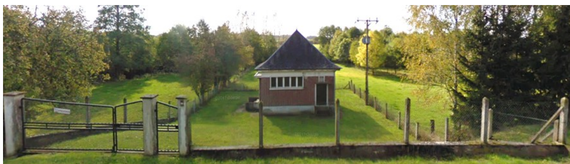
Figure 11 : Vue Station de pompage, captage BSS000EZDQ
