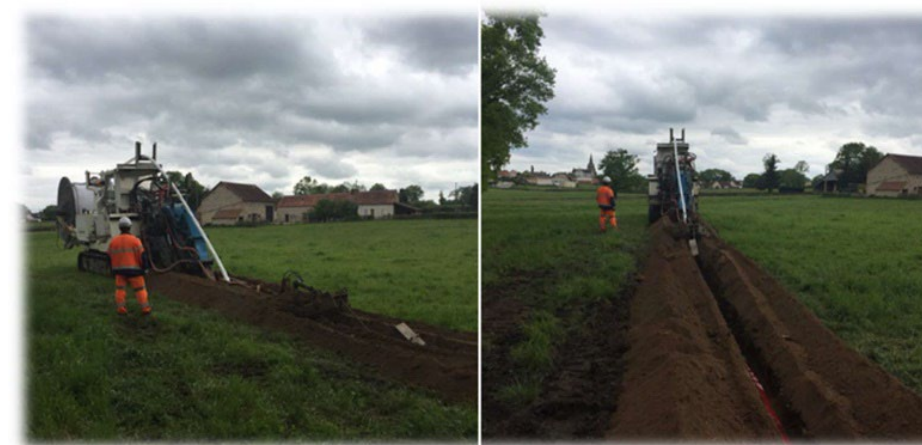
Figure 10 : Exemple de chantier d'enfouissement d'un réseau électrique en terres agricoles (source : Cegelec Infra)
