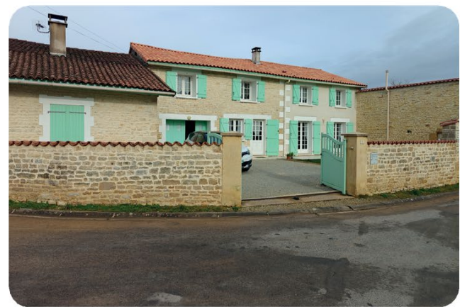
Bâtisse et murets du hameau de Pailleroux rénovés
