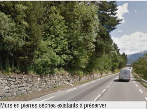
Murs en pierres sèches existants à préserver
