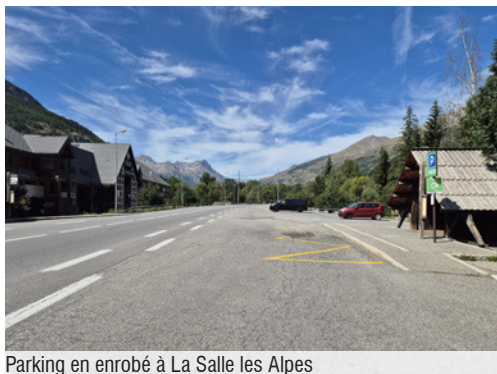
Parking en enrobé à La Salle les Alpes
