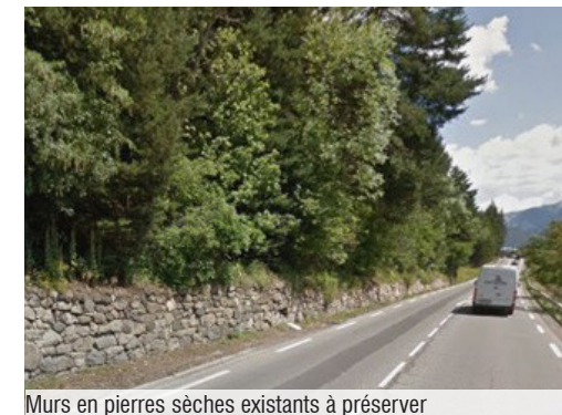
Murs en pierres sèches existants à préserver
