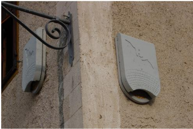
Figure 7 : gîte chiroptères en façade
