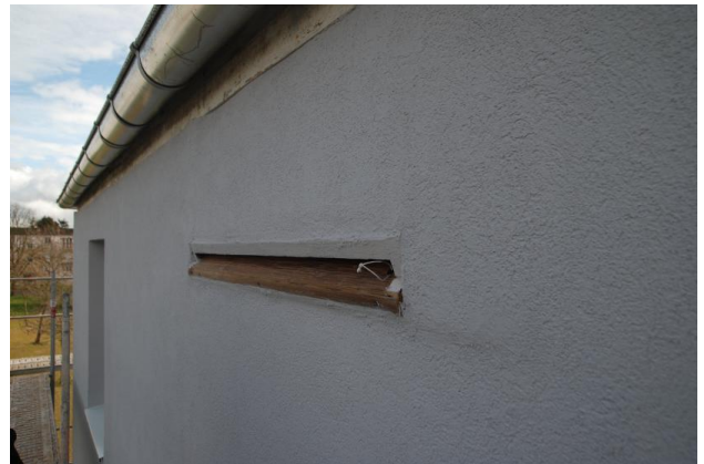
Figure 8 : gîte chiroptères intégré à l'isolant
