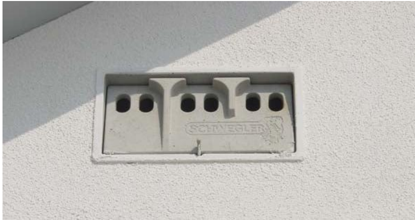
Figure 9 : nichoir à moineau intégré dans l'isolation thermique
