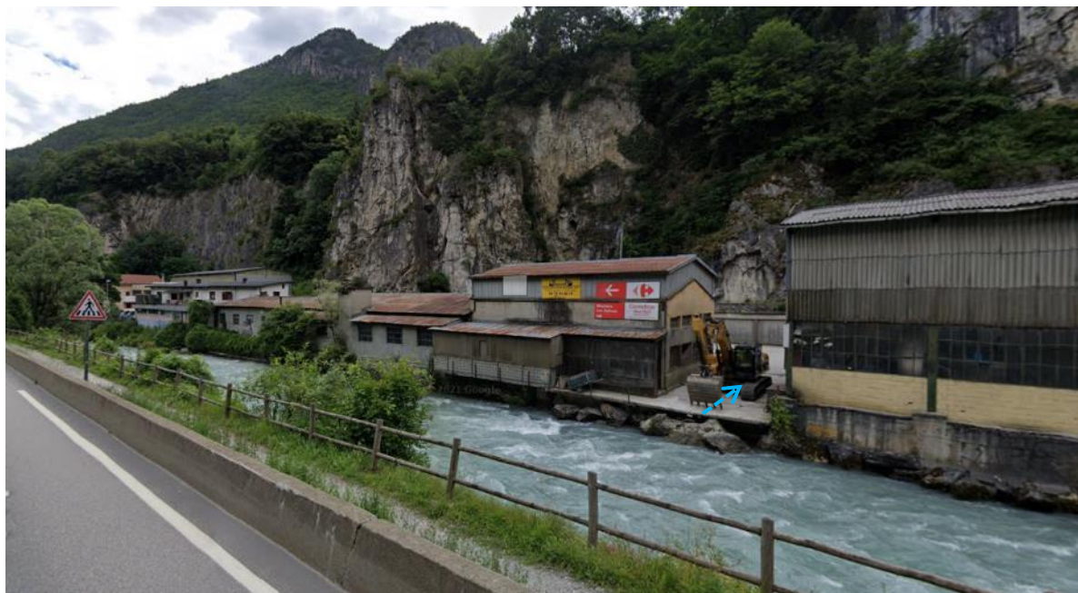
Figure 50 : Point bas d'intrusion des eaux en crue sur la ZA des Salins - LOMBARDI
