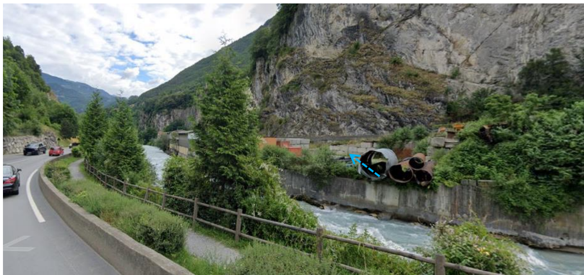
Figure 49 : Zone d'amorce des débordements sur la ZA des Salins - LOMBARDI
