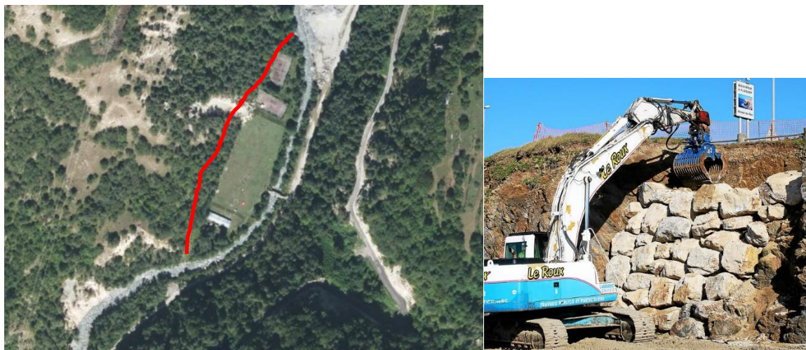
Figure 46 : Consolidation en enrochements du pied de butée de la falaise
