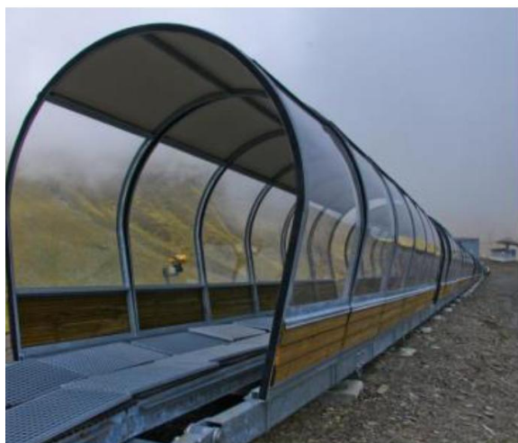
Exemple d'un tapis à l'architecture qualitative : arceaux mât et foncé et soubassement bois
