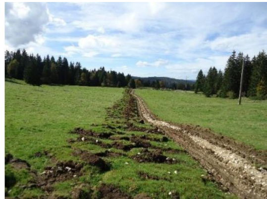
Figure 38 : illustration exemple de la méthode de stockage des mottes étrépees -©Karum
