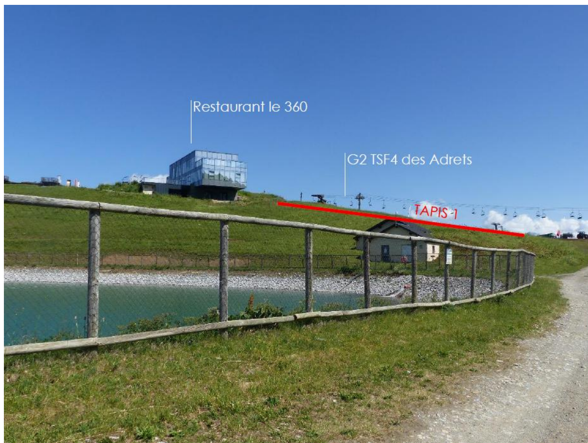
Figure 28 : Vue éloignée depuis le sud de la zone d'étude, à proximité immédiate de la retenue de Prajourdan - ©Karum
