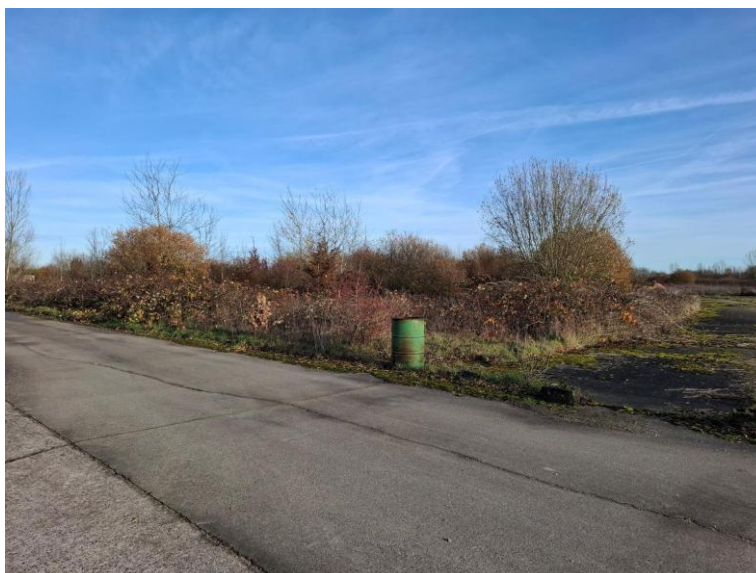
Prise de vue n°3 — Ouest — future entrée principale, bétonnée et dégagée (mars 2026)
