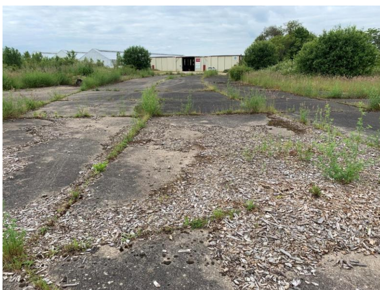
Prise de vue n°10 — entrée du site — état de la friche (juin 2024)
