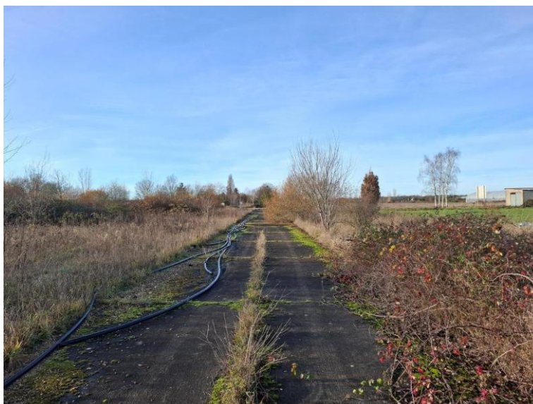
Prise de vue n°7 — Nord — état de la piste, tuyaux abandonnés (mars 2026)
