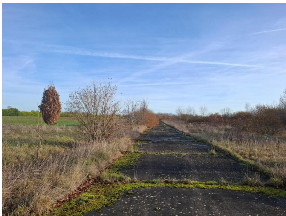
Vue générale du site — piste bétonnée existante (mars 2026)
