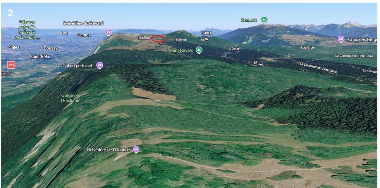
VUE DEPUIS LE BELVEDERE DE L'ORIONDE (SOURCE : GOOGLE EARTH)
