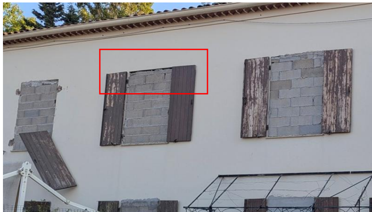
Anfractuosités dans le murage des fenêtres favorables aux chiroptères © ELAN
