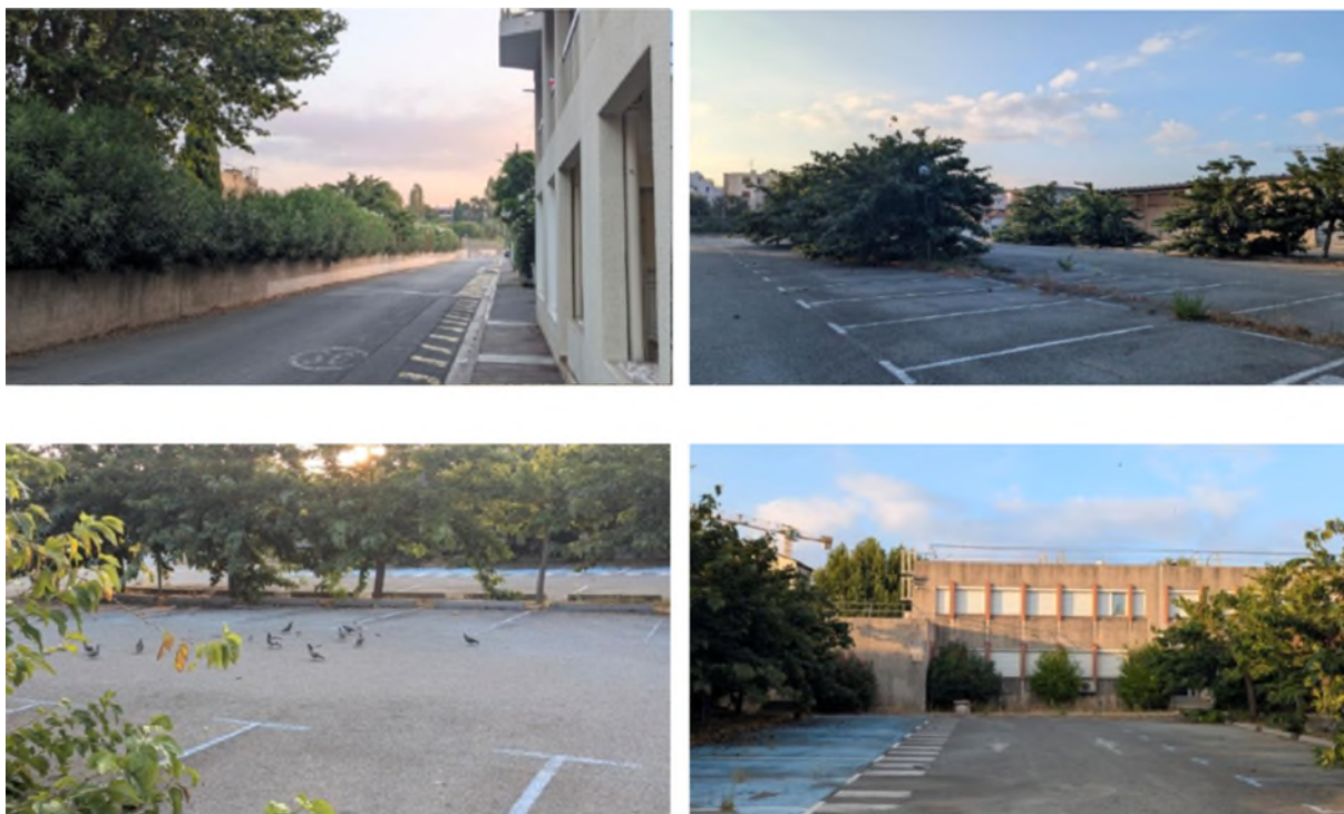
Figure 23. Photos du site - présence importante de dalles bitumées
