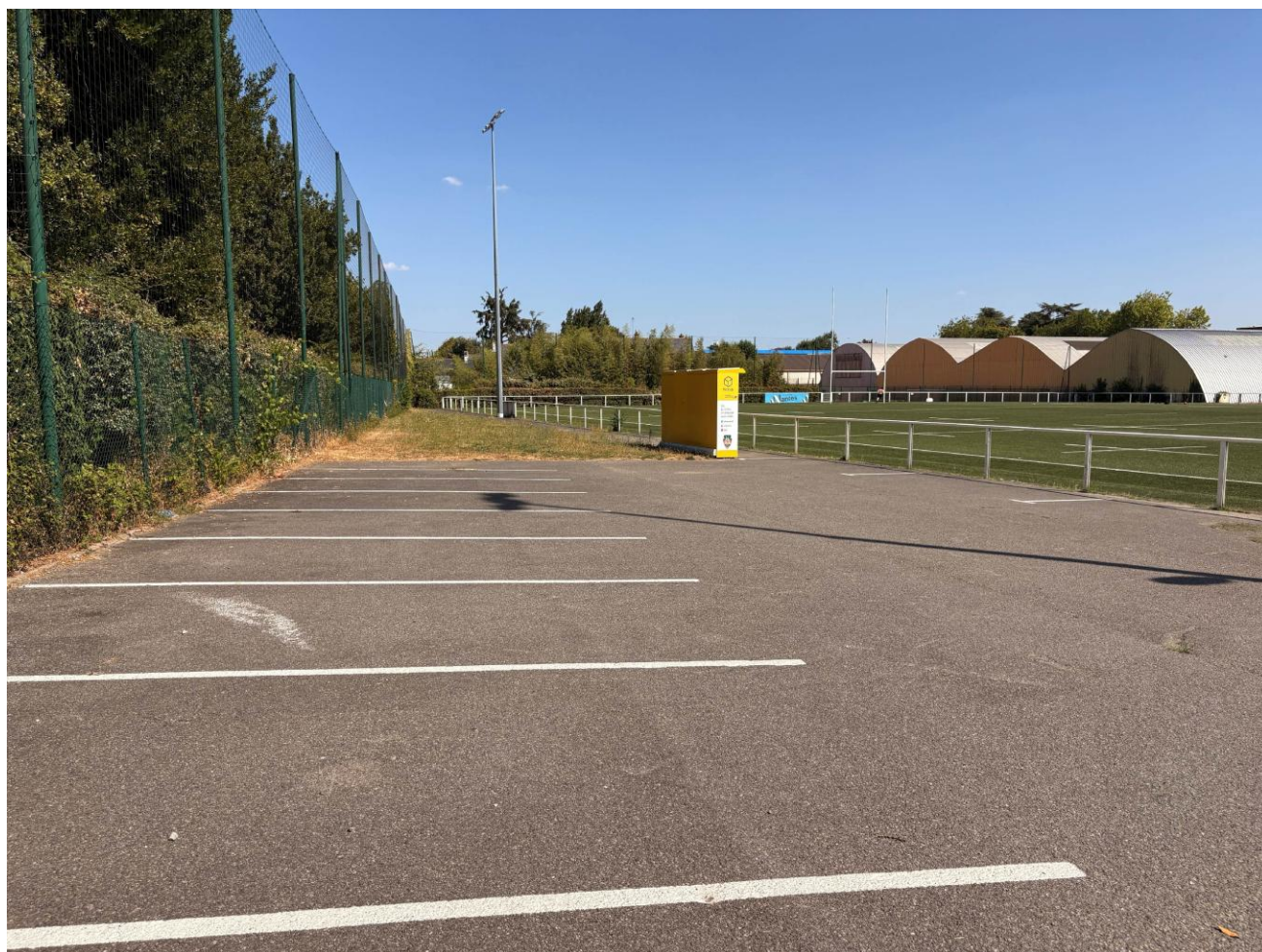
Figure 3 : Emplacement du futur vestiaire, source : Briand
