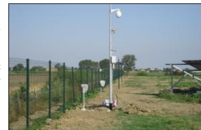
Exemple de mat de vidéosurveillance
