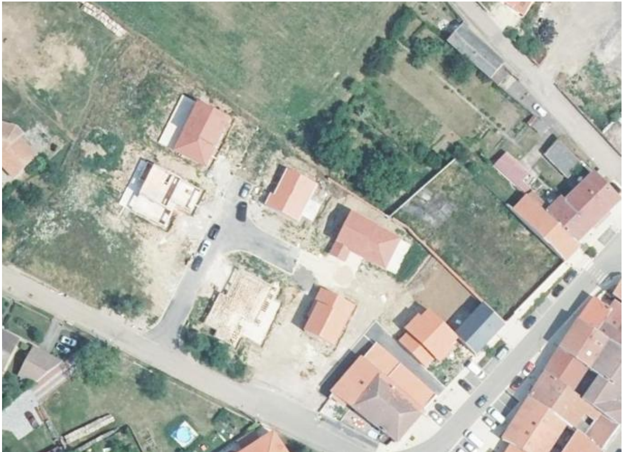
Vue aérienne du secteur concerné (Source : Géoportail)
