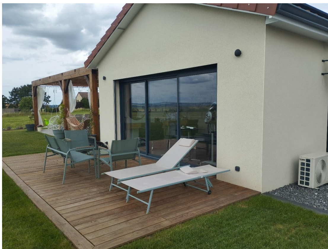
Extension édifée en zone A – Habitation localisée sur la parcelle 316 (Source photographique : Commune de Manoncourt-en-Vermois)
