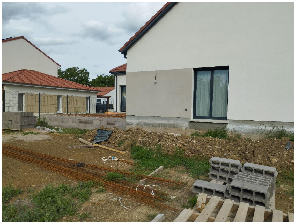
Habitation dont l'emprise est partiellement localisée en zone A (Source photographique : Commune de Manoncourt-en-Vermois)
