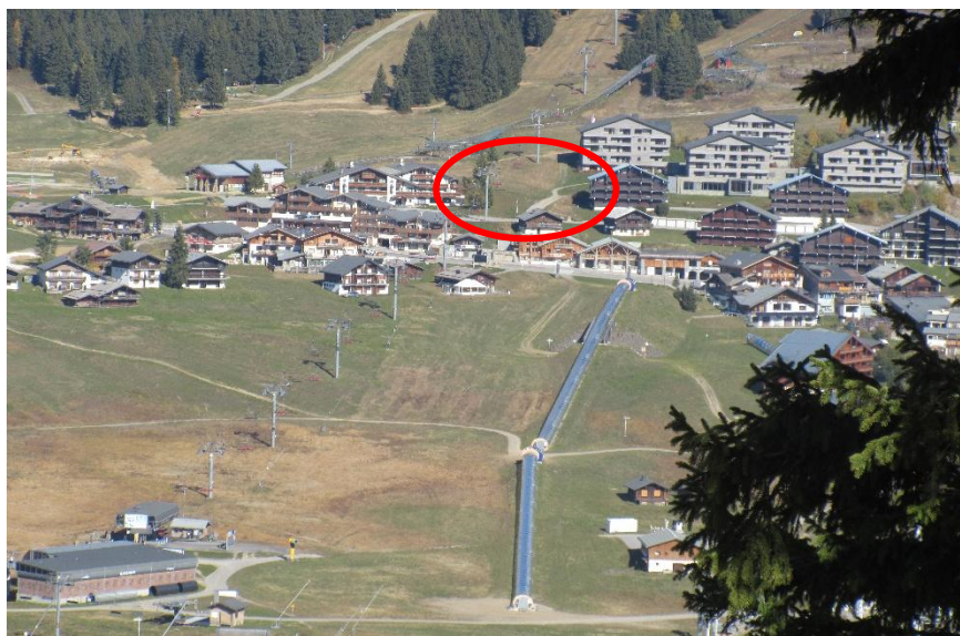
Photo 3 : Localisation du site dans la station des Saisies
