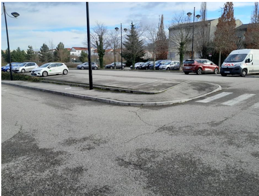
Vue du parking au nord-est du site
