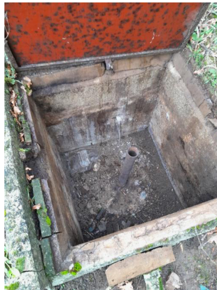
Vue de la zone de la cuve de fioul avec la trappe pour l'évent – partie nord ouest du bâtiment
