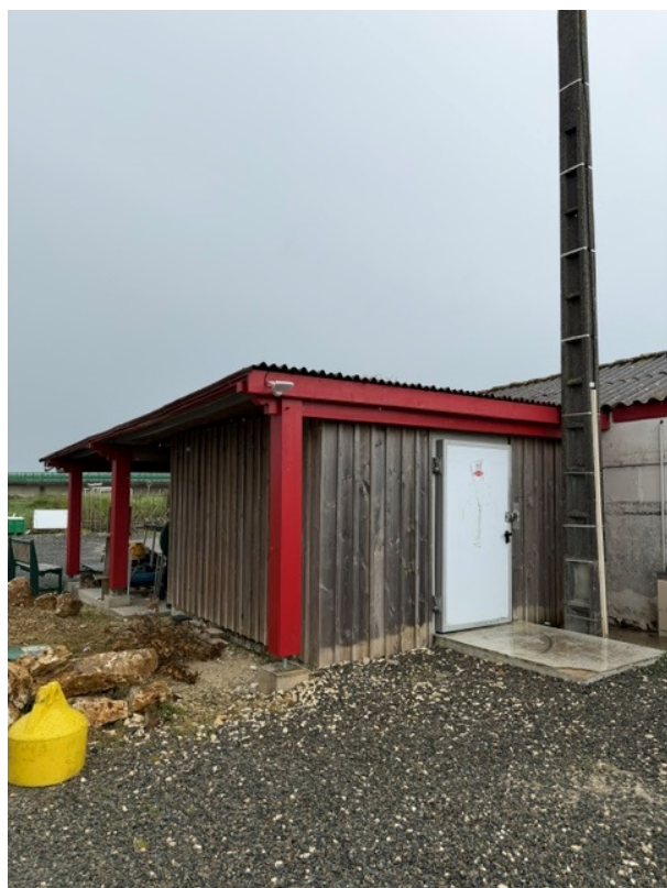
P1 - Environnement proche (chambre froide)
