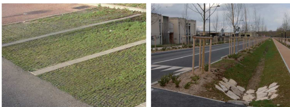
Figure 71 : Exemple de places parking enherbées non étanches et de noue
