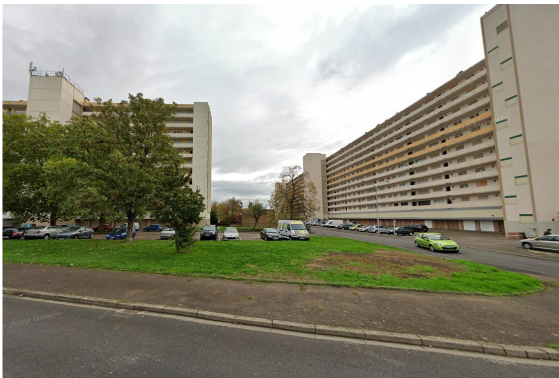
Photographie n°2 : Bâtiments rue Paul Chevreux (octobre 2022)
