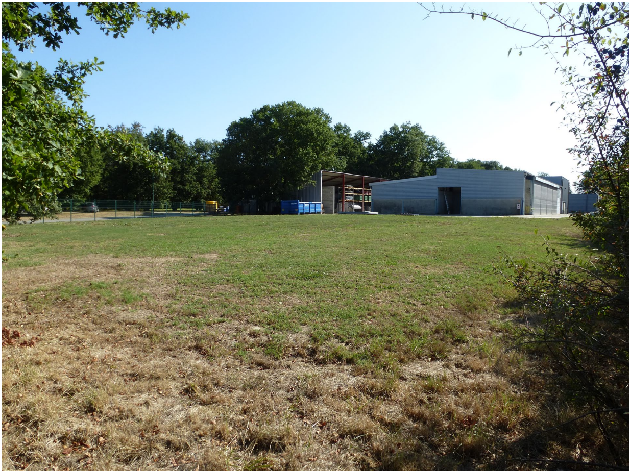
Figure 2 – Photographie du site en août 2026
