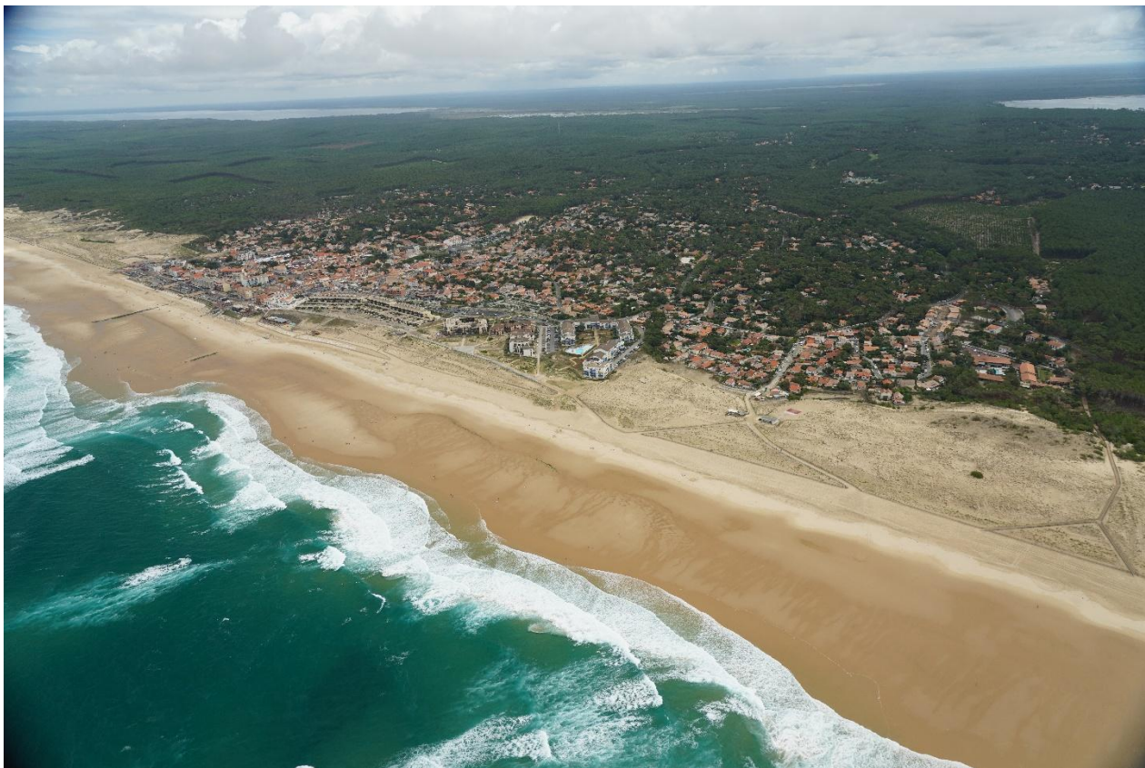
FIGURE 2. PHOTO 1 : VUE AERIENNE GENERALE DU FRONT DE MER DE LACANAU (OCNA, 2023).
