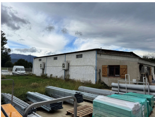
Vue proche 2 : Façade Nord Silo
