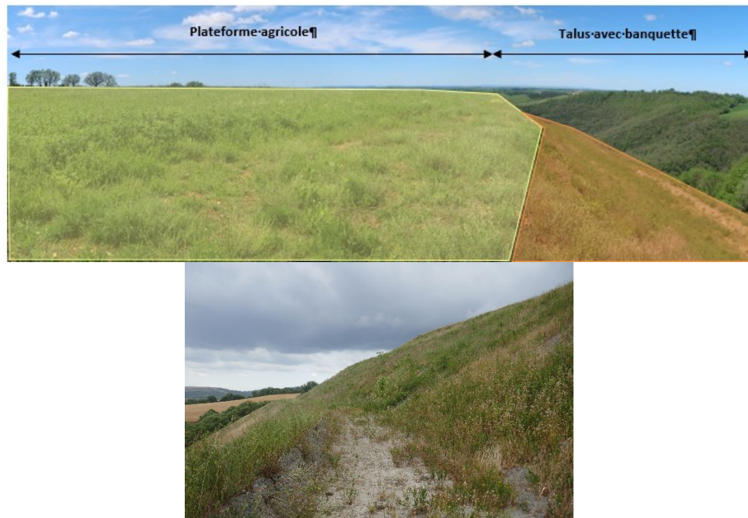
1- Vue Est du site d'étude, à gauche la plateforme plate et à droite le talus / 2- Vue d'une banquette entre deux talus
