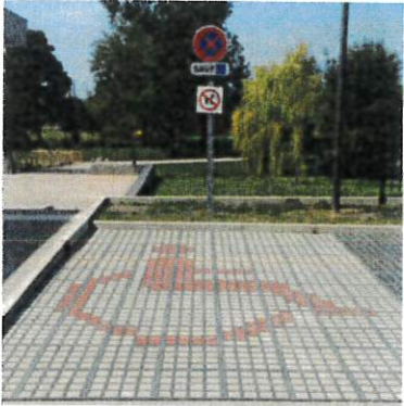
Places PMR en dalle pavé drainant
