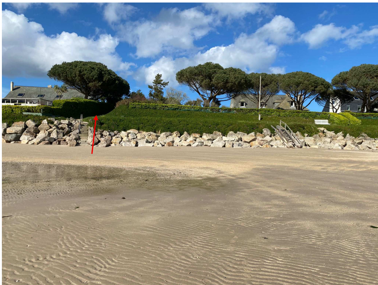
Photo 5 : Vue depuis la plage de l'escalier du chemin d'accès à la plage
