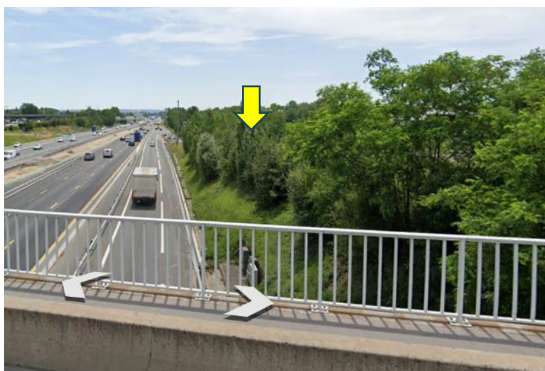
ILLUSTRATION – POINT DE VUE ELOIGNE – PONT PORTE DE LYON, AU-DESSUS DE L'A6 – EXTRAIT G.EARTH©2026
