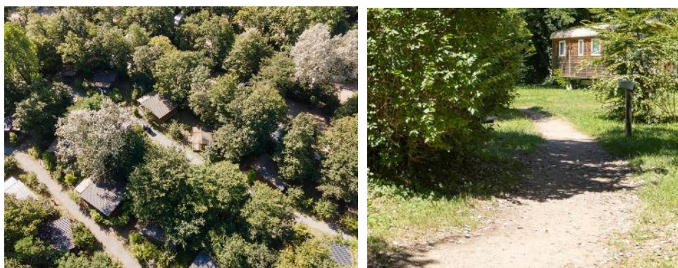
VISUEL DES CHEMINS CARROSSABLES PERMEABLES ET CHEMIN PIETON DU CAMPING DE LYON – CLICHES M.REYBOZ
