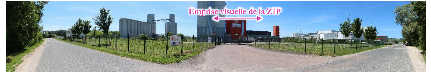
Photo 1 : Vue en direction de la ZIP (non visible), depuis la rue du Port au Vin, au niveau des silos Dumée (Source : BEJC)
