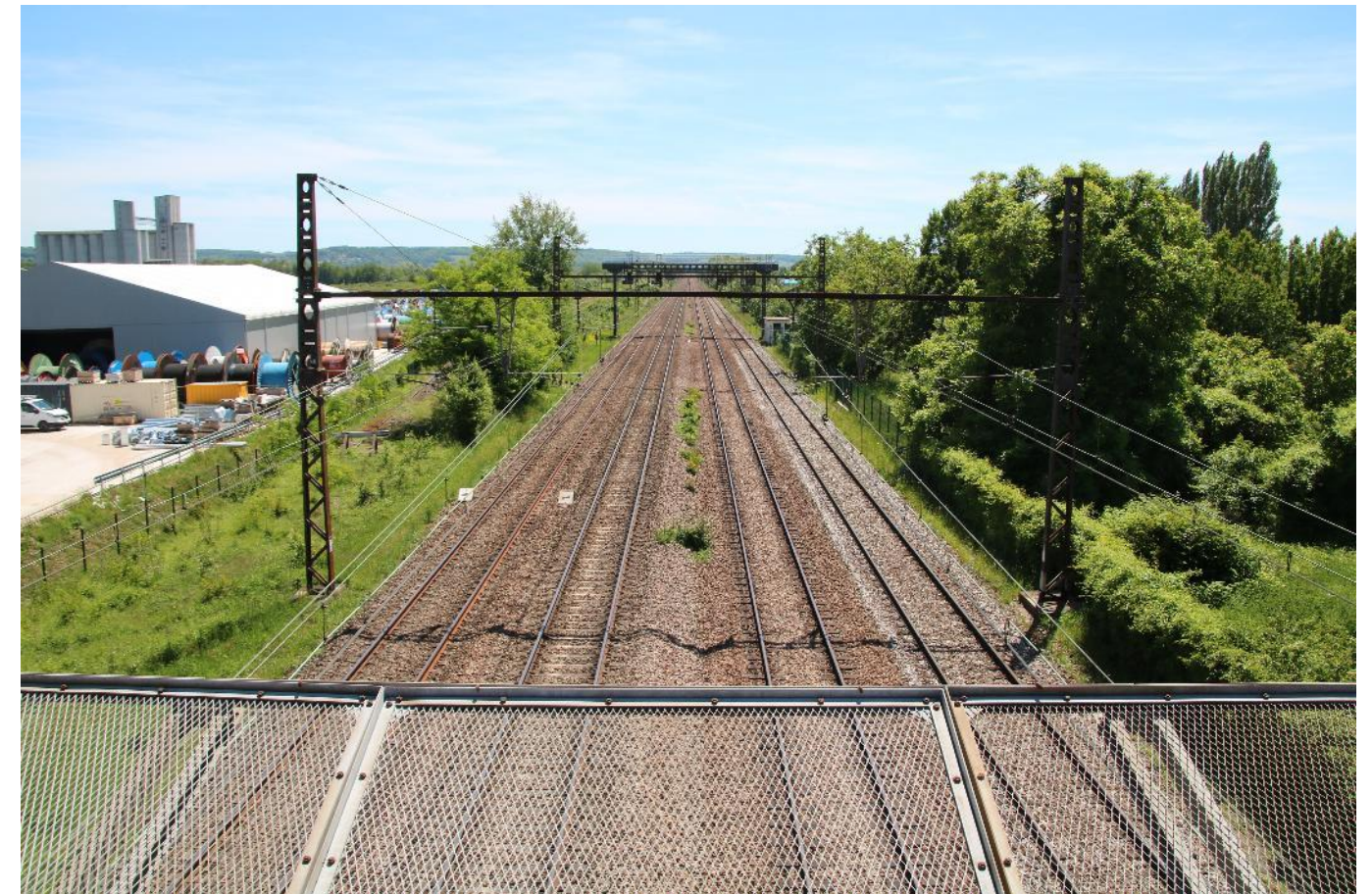
Photo 2 : Vue en direction de la ZIP (partiellement visible), depuis le pont sur la ligne PLM (ligne 830 000) (Source : BEJC)
