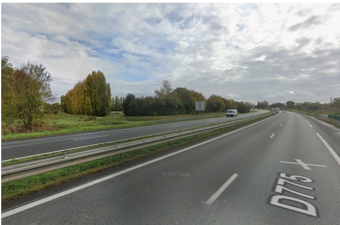
Vue 6 depuis l'ouest (et la D775) vers le projet (Google)
