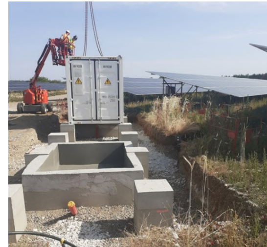
Fig.73 Pose des postes électriques sur les bacs de rétention
