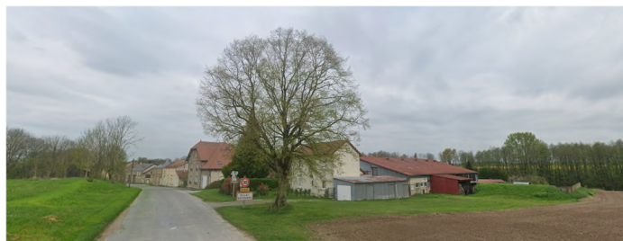
Fig.61 Vue de l'entrée Est de Ville-sur-Retourne
