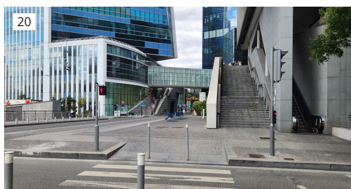
Fig.34 : Vue sur la rue des Longues Raies (TRANS-FAIRE, 2026)
