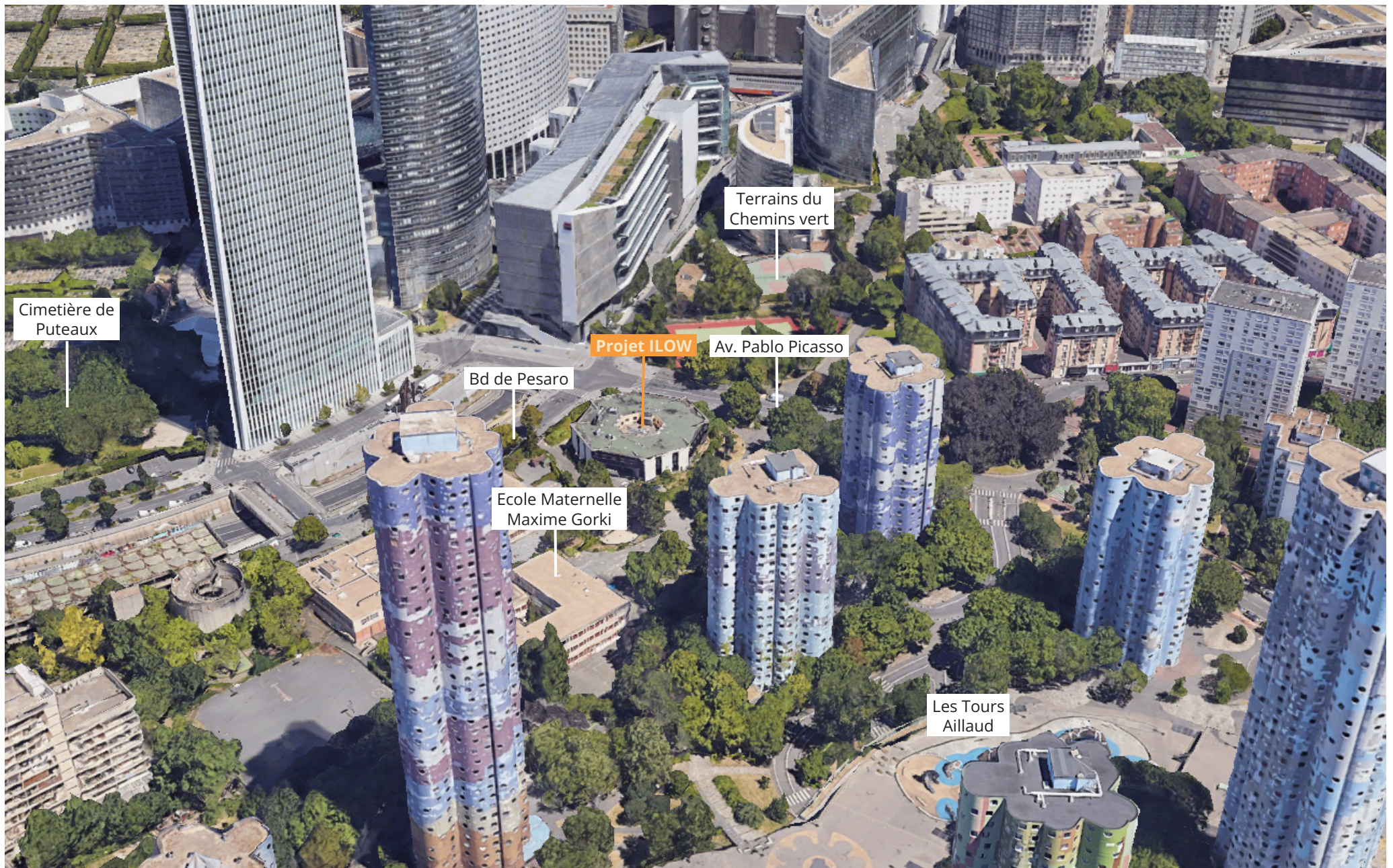
Fig.8 : Vue lointaine depuis le sud-ouest du projet (Google Earth, 2026)
